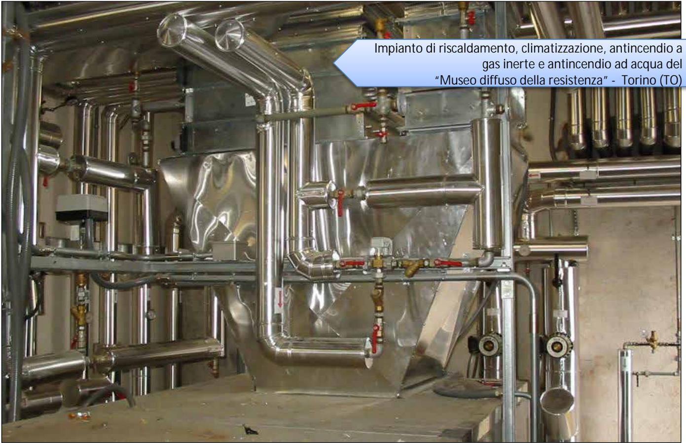
Impianto di riscaldamento, climatizzazione, antincendio a gas inerte e antincendio ad acqua del "Museo diffuso della resistenza" - Torino (TO)
